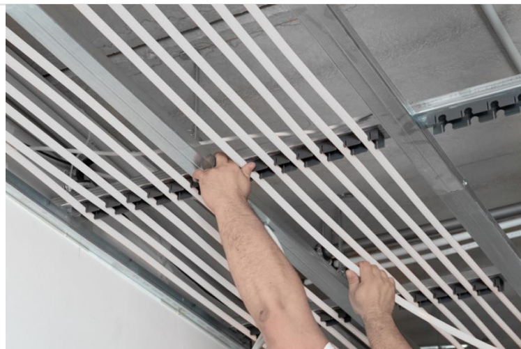
5. Pokládka potrubia RAUTHERM Silence podľa plánu.
