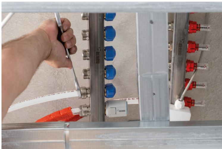
4. Pripojenie potrubia RAUTHERM Silence k rozdeľovaču pomocou skrutkového spoja.
