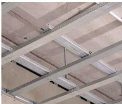
Krok 1: Inštalácia spodnej konštrukcie
