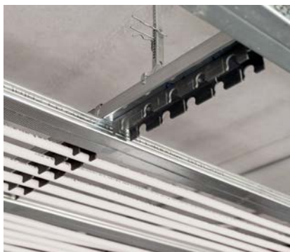
Krok 2: Montáž lišty RAILFIX a potrubia RAUTHERM Silence
