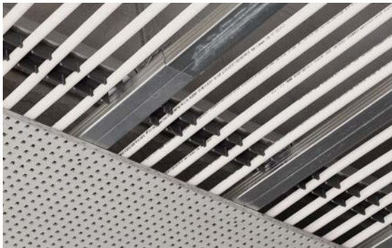
Obr. 1-1 Systém stropného chladenia RAUTHERM RAILFIX
